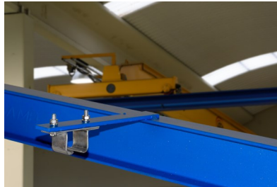
PLETINAS SOLDADAS A LA VIGA
