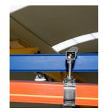
Installez les barres de ligne LM-60Q aux points de support en veillant à ce que la ligne de signalisation jaune «terre» soit toujours du même côté.
