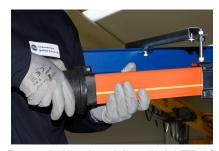
Fermer le bouchon à l'extrémité TE-4Q de la ligne pour eviter les contacts électriques indésirables.
