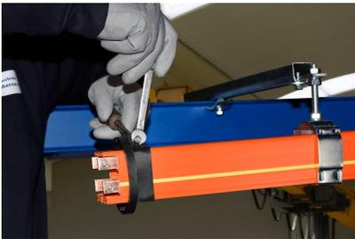
Monter l'alimentation en bout AE-4Q et le bouchon TE-4Q à l'autre extrémité de la gaine
