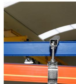
Installez les barres de ligne LM-60Q aux points de support en veillant à ce que la ligne de signalisation jaune «terre» soit toujours du même côté.
