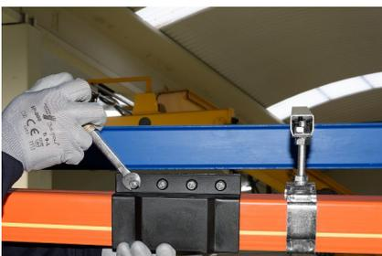
Montar y apretar la tornillería de los empalmes EMPC-4. Comprobar correcta alineación entre viga y línea eléctrica.
