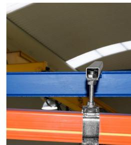
Instalar las barras de PVC LC en los puntos de soporte, respetando que la línea amarilla de señalización de "tierra" queda siempre al mismo lado.
