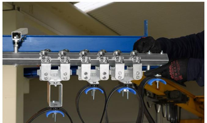
Insérez les chariots montés avec le ou les câbles dans le profil en commençant par le chariot entraîneur, puis ensuite les chariots mobiles et terminer par le porte câble fixe. Le câble électrique doit être monté sans rotation. Serrez le chariot fixe à la fin du profil.
