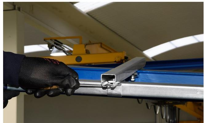
Joignez les profils grâce à l'utilisation d'éclisses qui garantissent la continuité entre les deux barres de profil. Serrer les vis une fois que l'éclisse a été placée au milieu des deux sections de profil. Répétez la même opération pour le reste des sections de profil .
